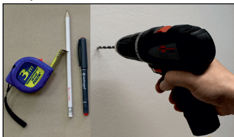
4. Na určeném místě kde je vyvedený napájecí kabel vyměřte a vyvrtejte montážní otvory.
