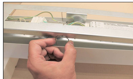
6. Připojte napájecí kabel do svorkovnice.
