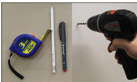
5. Na určeném místě vyměňte a vyrtajte otvory pro ukotvení svítidla.
