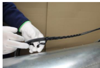
Uvolněte přívodní kabel k příslušné trubici odvinutím pásku
